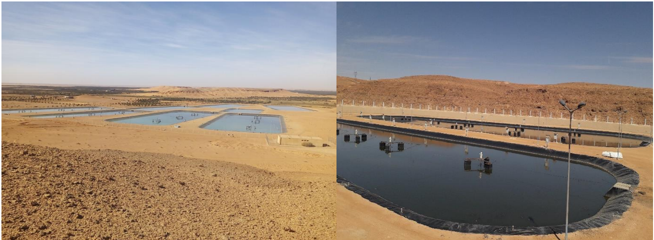
Figure 11: photos représentant les stations d'épuration à Ghardaia
