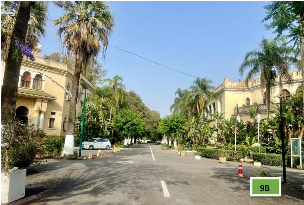
Figure 9B. Sous-station comprenant les bâtiments du Génie rural et des ateliers (Photo originale)
