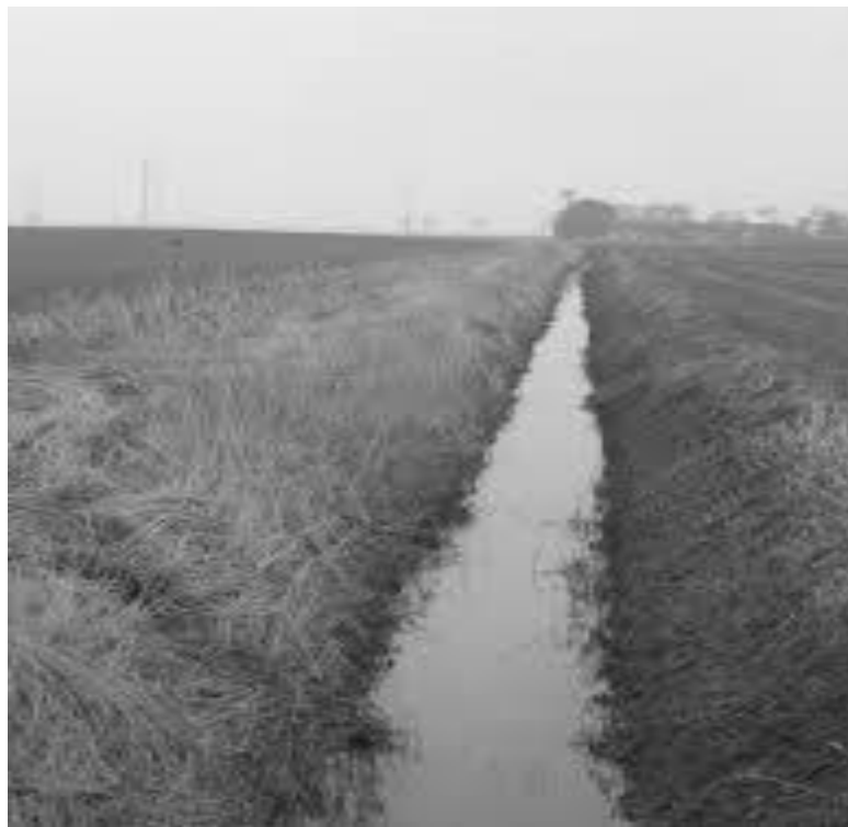
Photo 5 : Drainage par fossés à ciel ouvert (Mermoud, 2006)
