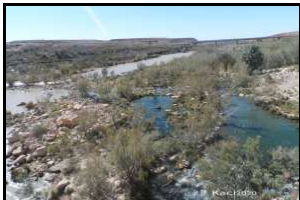
Figure 4: Eau usée au niveau du barrage de Djorf Torba
