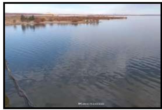
Amont du barrage
