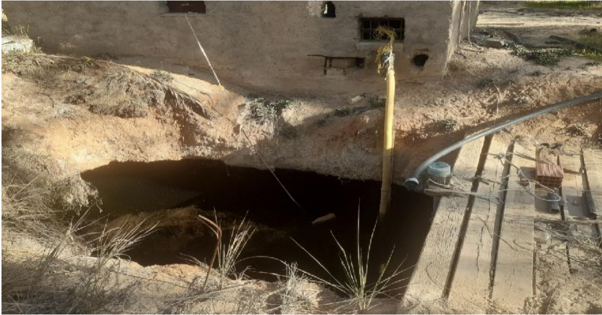
Figure 6 : Puits de deux mètres de profondeur ( Birdjemma ) réalisé depuis les années 1940 dans la zone d'El Amri
