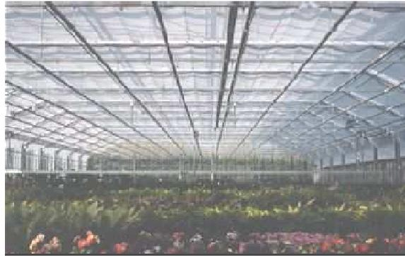
Figure. I.3 : Ecrans thermiques déployés en serre verre
