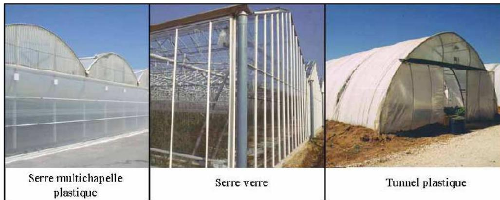
Figure. I.1: Les trois principaux types de serres
