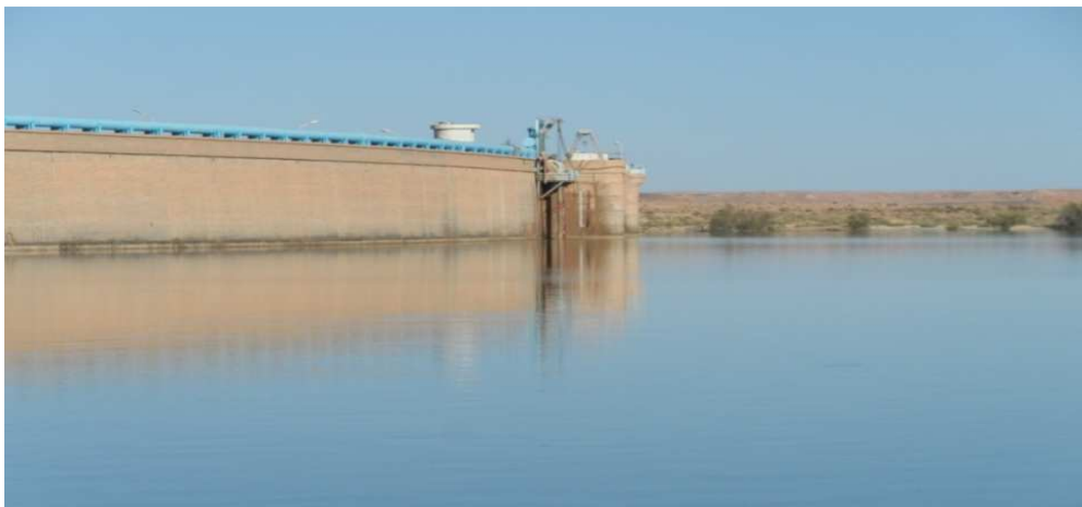
Figure 2 : Barrage de Djorf Torba (Partie Amont) (original 2013).
