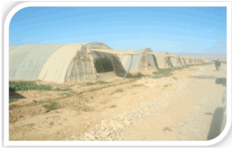
Dédoublément des serres au niveau du projet
