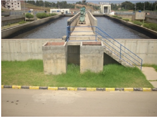
Figure 27: Représentation du Bassin d'aération de la station d'épuration de Boumerdes, Mai 2010.
