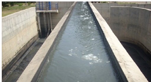
Figure 23 : Représentation de l'ouvrage de l'arrivée de l'eau de la station d'épuration de Boumerdes, Mai 2010.
