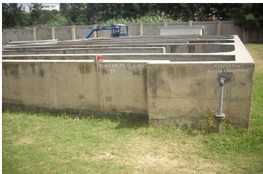
Figure 30 : Représentation des ouvrages de désinfection de la station d'épuration de Boumerdes, Mai 2010.
