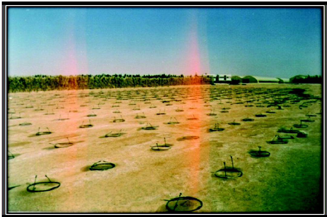
Photo 5. Installation d'un système d'irrigation goutte à goutte à moyen débit (50 l/h).
