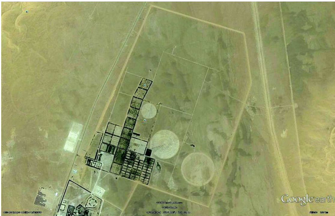
Photo 1. Périmètre du Projet Agricole de Sonatrach à Gassi Touil.
