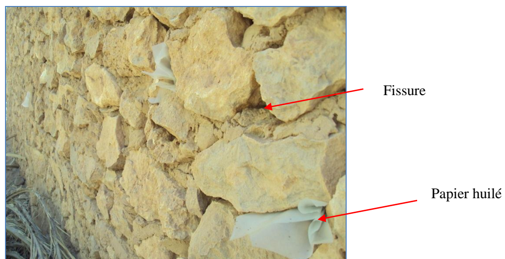
Fig. 29 – Installation des pièges huilés dans les fissures du mur (Originale)
