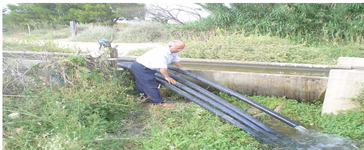
Figure 16: Dérivation de l'eau du canal principal 1
