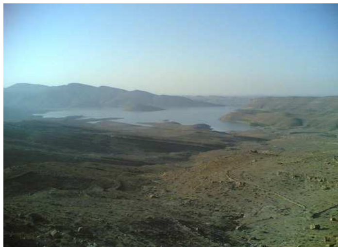
Figure 7: Vue en amont du barrage du K'sob
