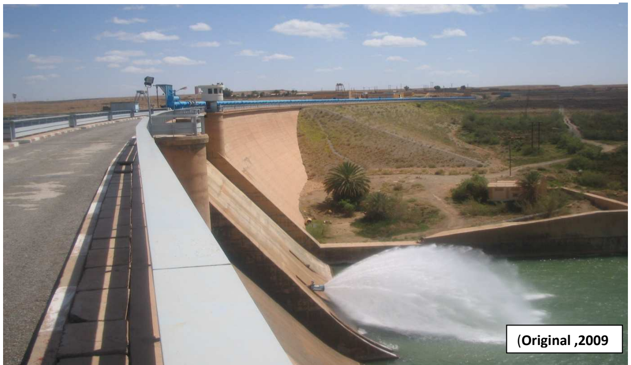
Figure n°2 : Vue sur le pont du barrage de Djorf Torba
