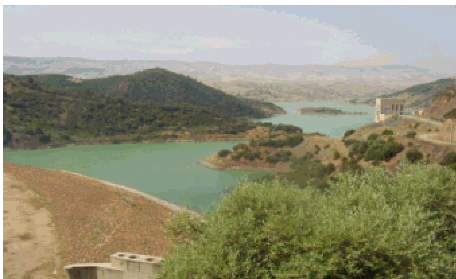
Figure n°12 : Le barrage de Bouroumi
