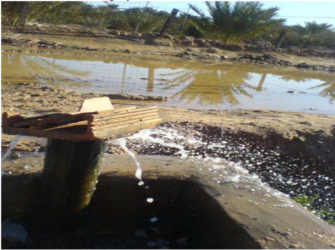
Photo 4: les conflits intra-groupes et la difficulté d'entretenir contre les fuites d'eau
