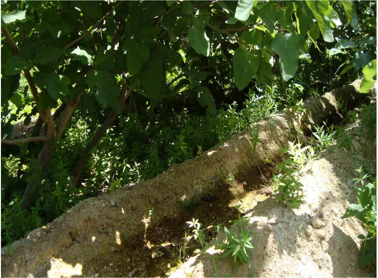
Photo 9: L'amenée d'eau par la seguia: une conduite très énergivore et peu efficace.
