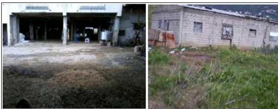
Figure 58. Photos de bâtiments d'élevages bovins. Région de Fréha (2013). © A MOUHOUS. 2014
