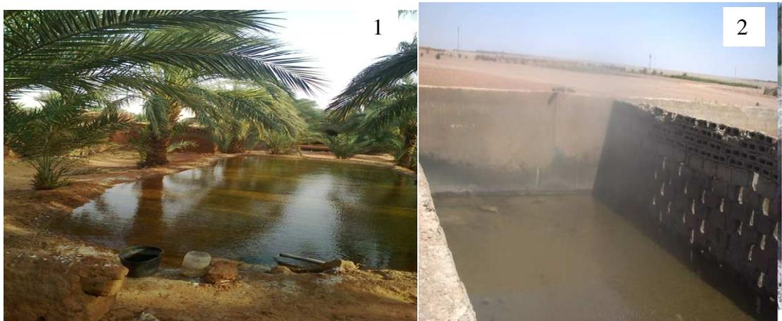
Fig. 10 : Bassins d'accumulation des eaux d'irrigation 1 bassin en Argile 2 : Bassin en ciment" utilisé généralement pour accumuler les eaux de pompage
