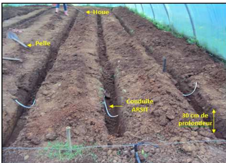
Figure 25: Pose des conduites ARSIT
