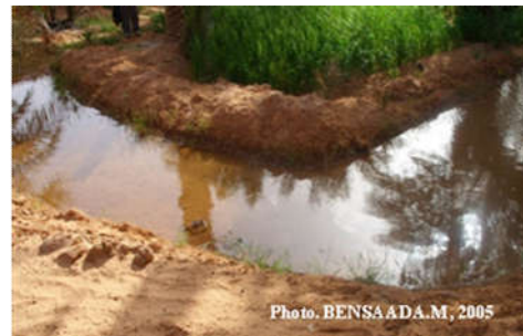
Photo 5 : Madjen construit en argile en forme L
