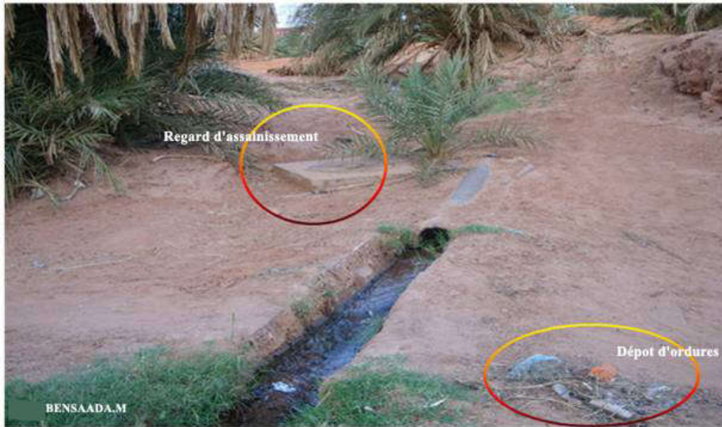
Photo 24 : présence d'un regard des eaux d'égout à proximité d'un canal de la foggara de M'ghaer
