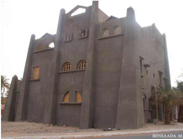
Photo 36: Construction nouvelle en ville de Timimoun
