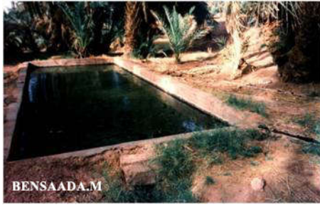
Photo.12 : Majen en béton
