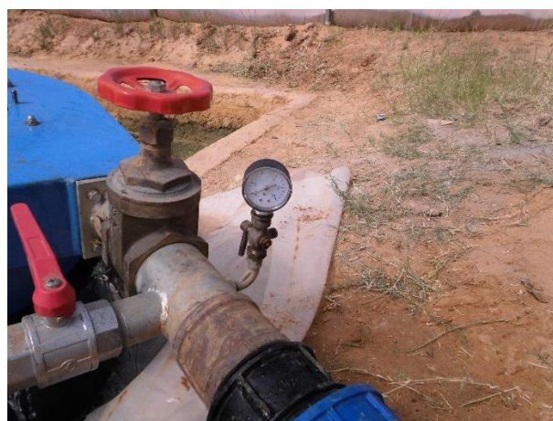
B- Manomètre indiquant une pression de fonctionnement nulle
