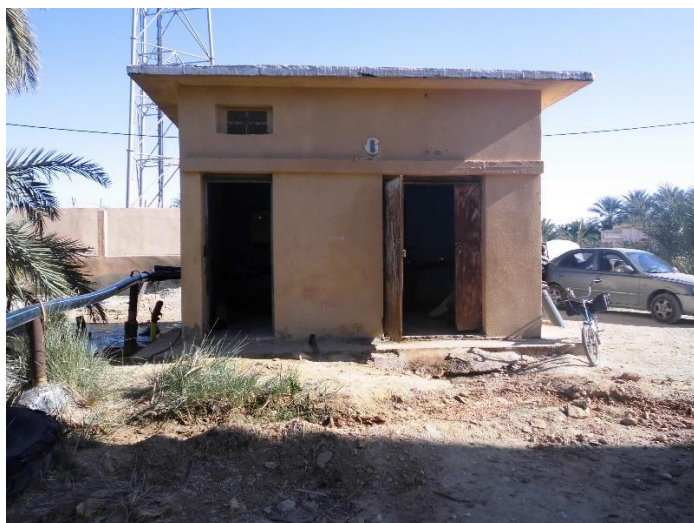
A- Abris de la tête de forage et système de distribution
