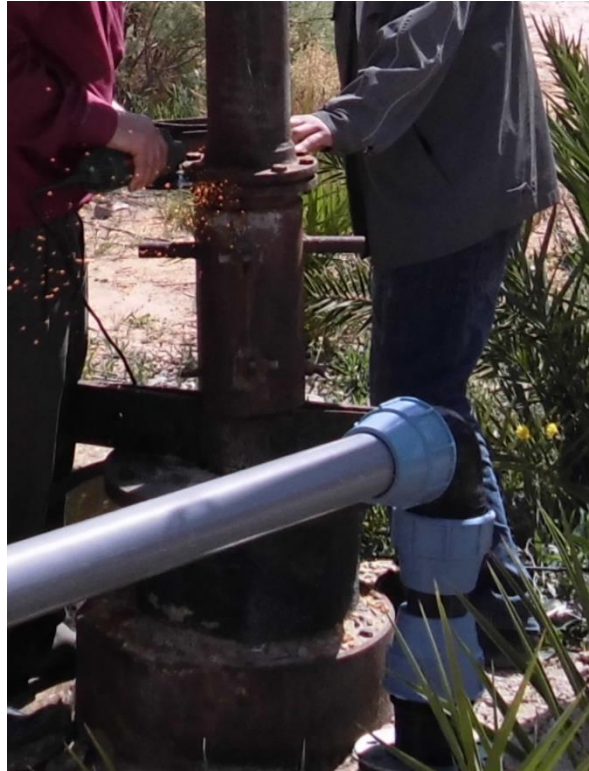
Figure 40 : Tête du forage 2 – Hassi Benabdallah, avant modification
