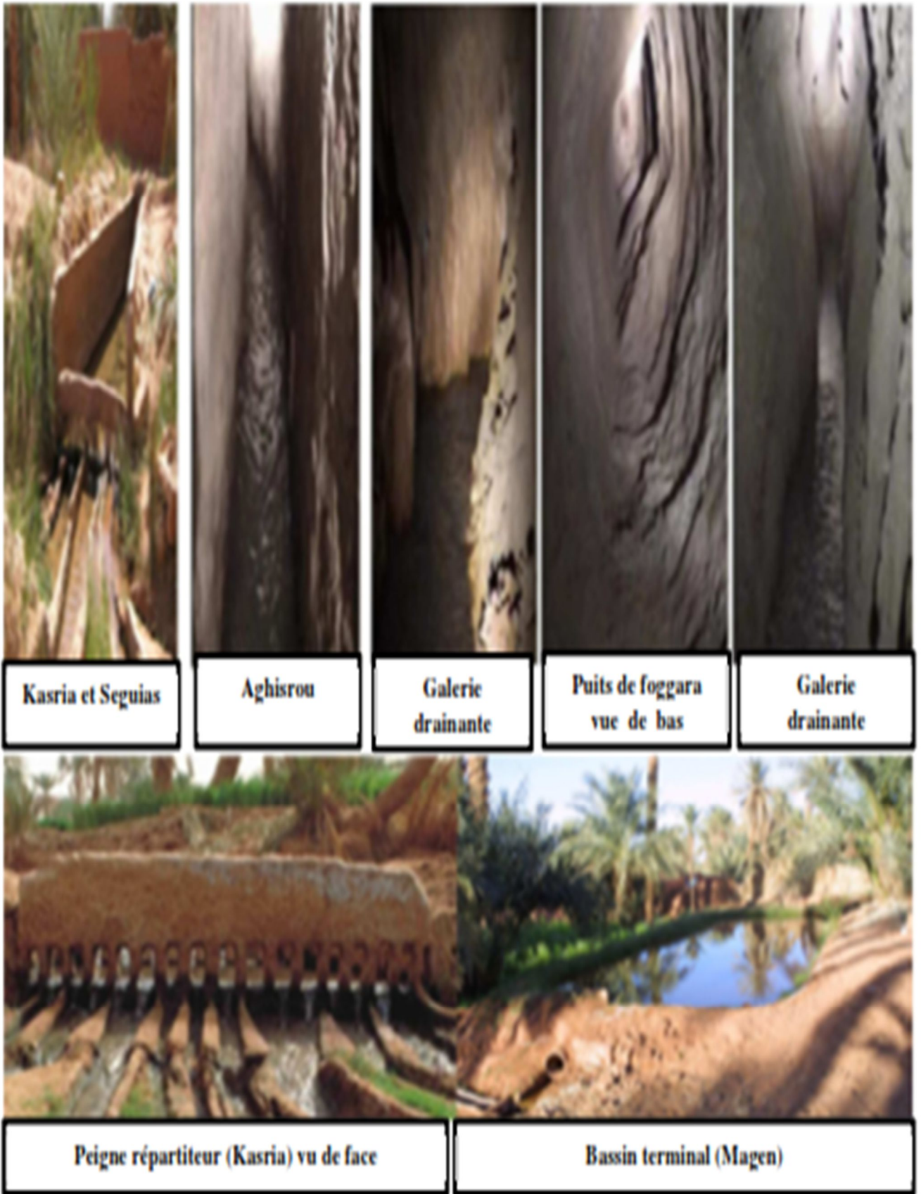
Planche 1. Ensemble d'éléments d'une Foggara (Benhamza, 2013).
