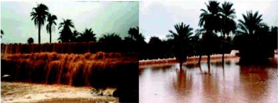
Photo 20: Diques de rétention dans la vallée (avant et après une crue)
