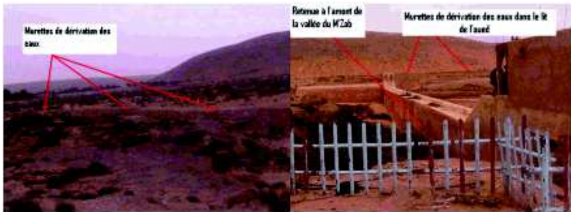
Photo 18 : Barrage de dérivation (droite) et digues en pierre dans le lit de l'oued M'Zab (gauche) à l'amont de la Vallée du M'Zab
