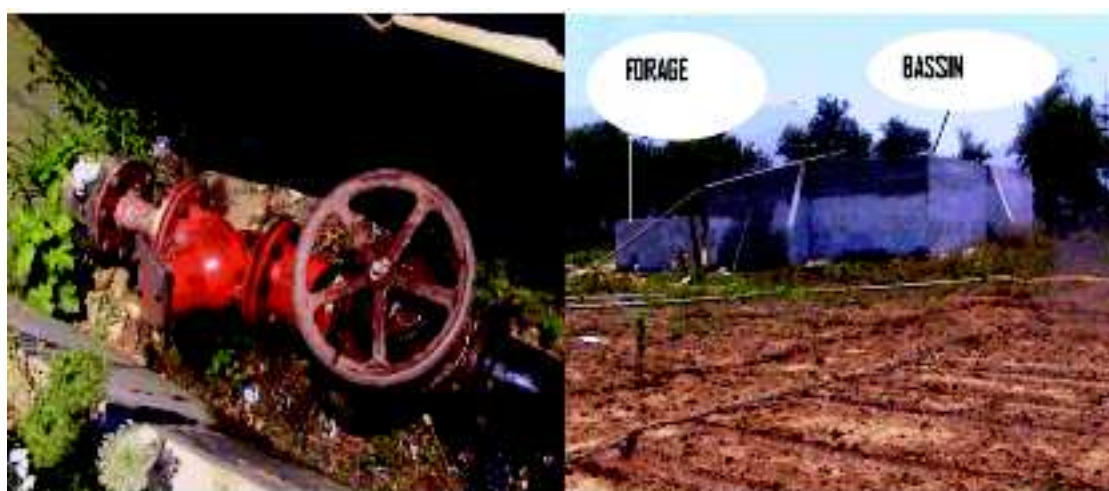
Photo 2 : Prise d'eau depuis le réseau du périmètre de la Mitidja Ouest tranche I gauche), et forage au premier plan, à droite (même exploitation)
