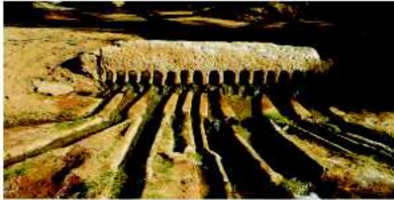
Photo.14 : Répartiteur d'eau (amont) et seguias de transport vers les parcelles (aval)
