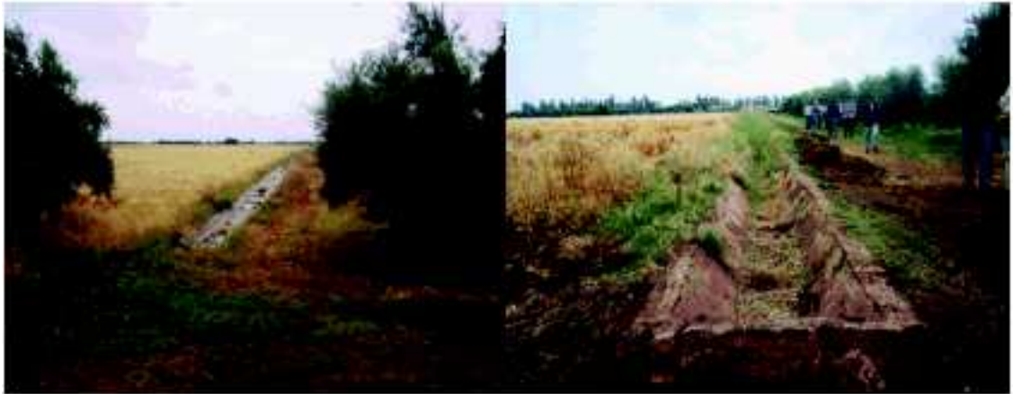
Photos 34 ; 35 : Canal recouvert d'un film plastique au Tadla (gauche) ; canal en béton au Tadla (droite)
