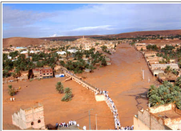
Figure III.11 : Oued M'Zab en crue (Pont Mlika 01 octobre 2008)
