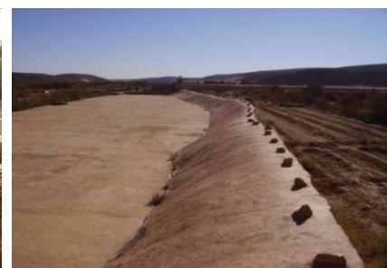
Barrage El Atteuf
