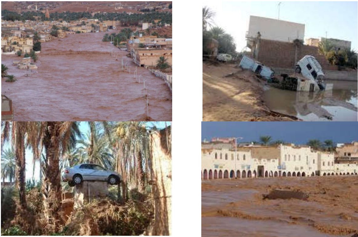
Figure III.15 : Quelques exemples de dégâts de la crue 01 octobre 2008
