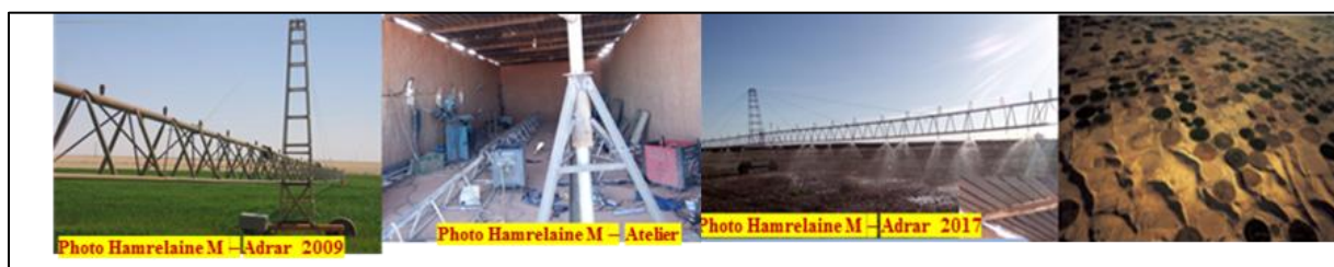
Figure 10: Pivot Artisanal de Oued Souf à Adrar. Source : Photos personnelles Adrar
