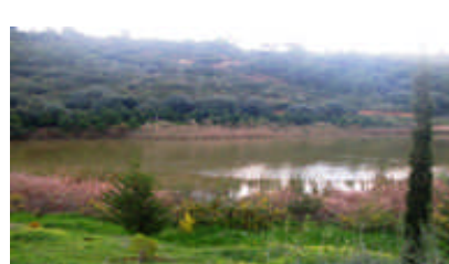
Figure 114 : Digue de Sidi Abdellah, Wilaya d'Alger. (Photo SAIFOUNI A., 2012)
