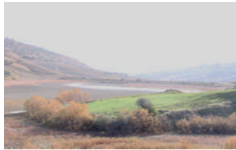
Figure 115 : Retenue collinaire de Thalassa. Wilaya de Chlef (Photo : SAIFOUNI., 2016)
