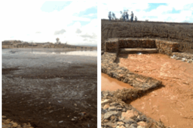
Figure 4: Zone d'épandage et ouvrage d'écrêtement.
