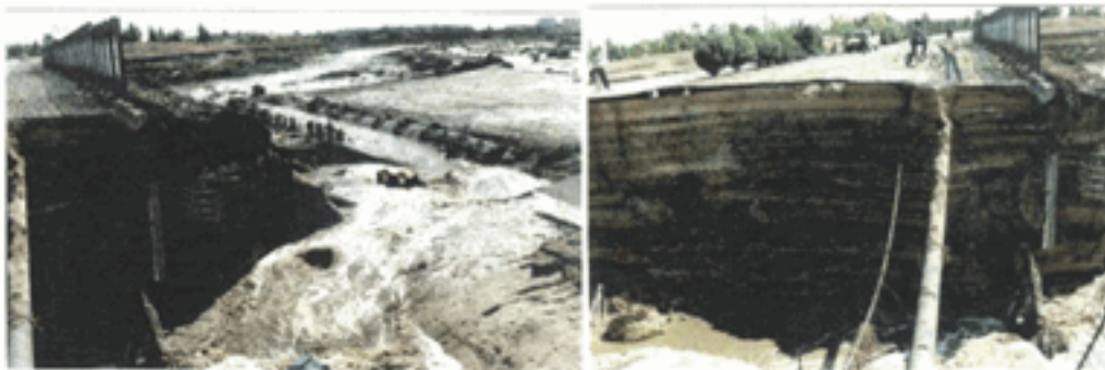
Figure 3: Déviation canal sud de l'oued Mekerra.
