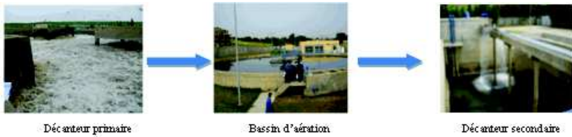
Figure 2. Les étapes de traitement des eaux usées
