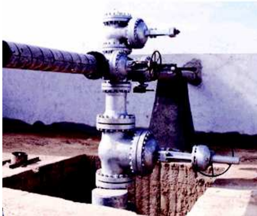
Photo 1 :Tête d'un forage du Continental Intercalaire à Zaouiet Riab, Djamaa.
