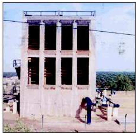
B : Refroidisseur à ventilation forcée
