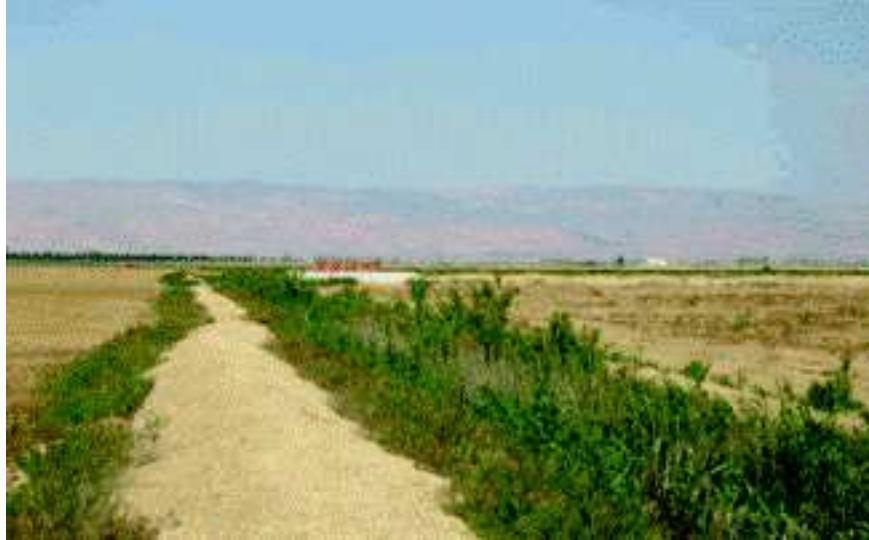
Photo n°02 : Drain primaire complètement enherbé (INSID, 2008)
