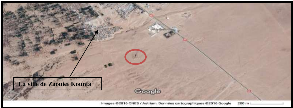
Figure 20 – Vue satellitaire de la station de Ksar El Mnassir (Google maps, 2016 modifiée).
