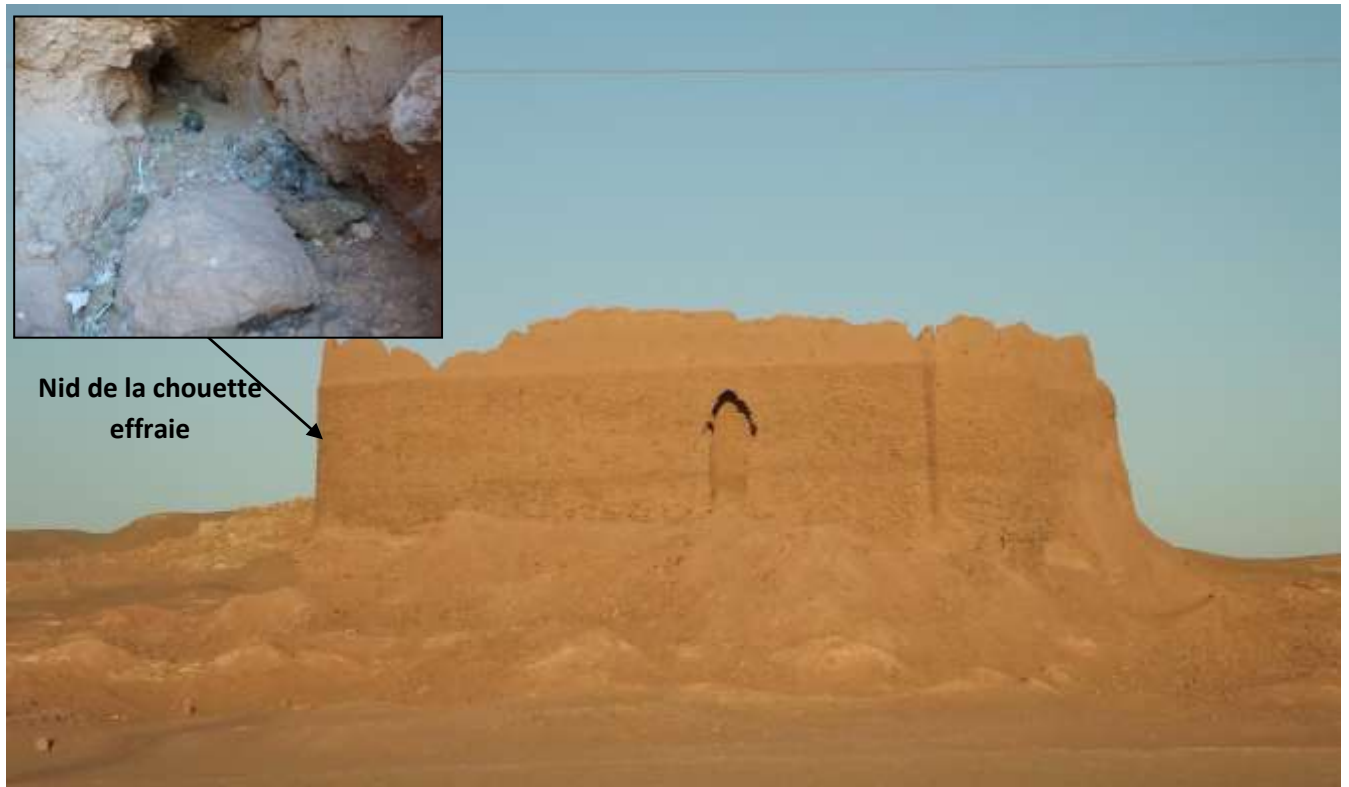
Figure 23 – Vue générale de Ksar Lyhoudi (DJETTI, 2014).
