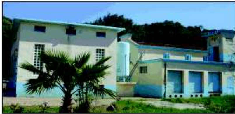
Figure 35 : Station de pompage située au Nord Est du lac de Réghaïa
