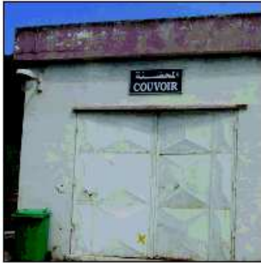
Figure 29 : Couvoir au niveau de la rive Est
