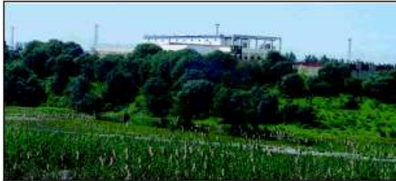
Figure 36 : La Station d'épuration au niveau de la rive Ouest du site d'étude
