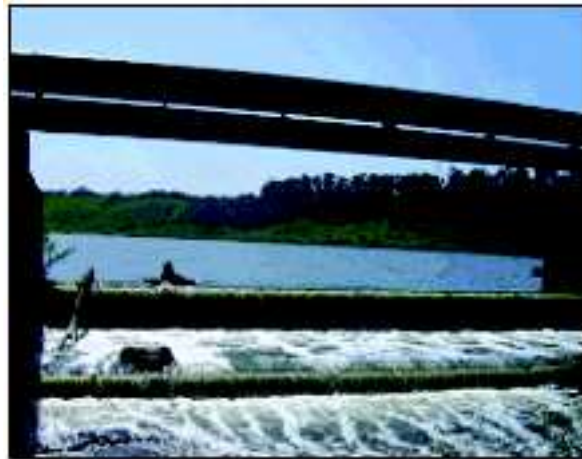
Figure 03 : Vue de la digue
