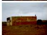
Photo n°8 : Habitat rural réalisé dans le cadre du PPLCD de la localité de Louïbed, Commune de d'El Gueddid
