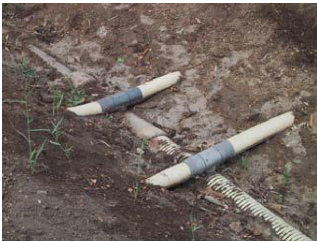
Fig.14 : Raccordement drain - collecteur
