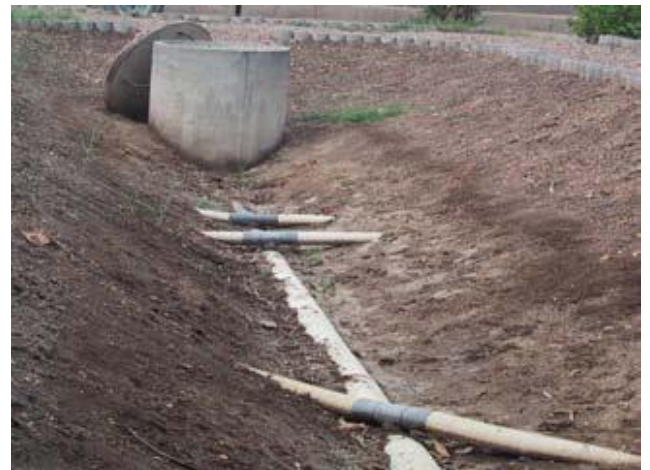
Fig.14 : Raccordement drain - collecteur
