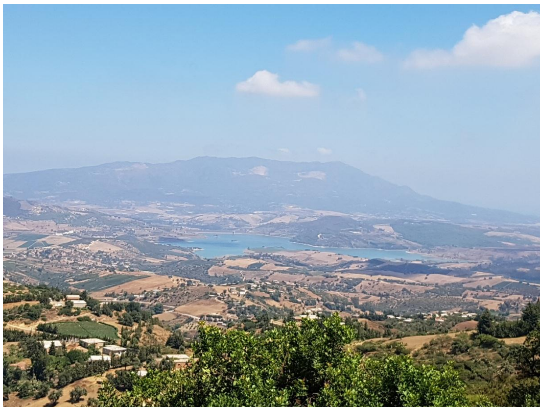
Photo 3 : Vue générale sud vers le barrage de Boukourdane et le massif de Chenoua au nord du bassin
