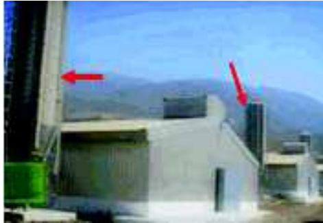
Photo 4 : silos à l'entrée du bâtiment
