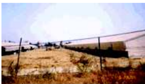
Photo 2 : Bâtiments du centre de Corso
