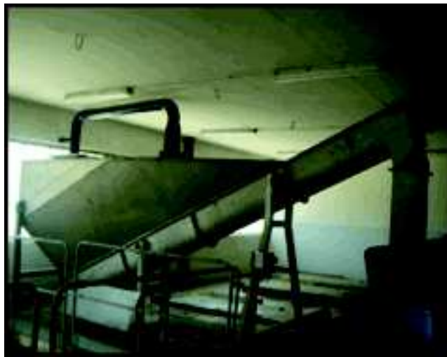
Figure VI.7: Classificateur à sables de la STEP Baraki, année 2011
