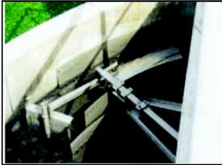
Figure II.8 : Système de raclage d'un dégazeur
