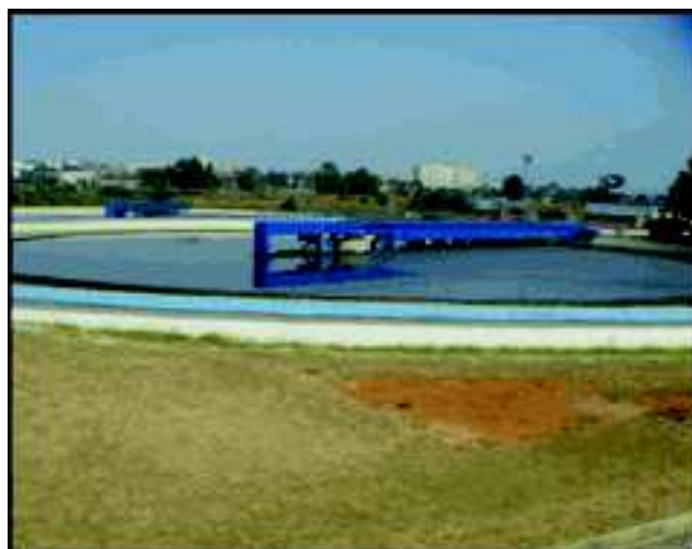
Figure VI.10: Clarificateur de la STEP Baraki, année 2011
