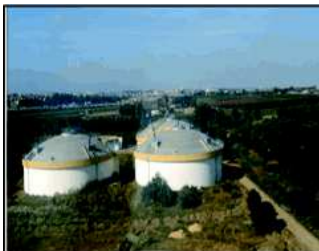
Figure VI.15 : Digesteur de la STEP Baraki, année 2011
