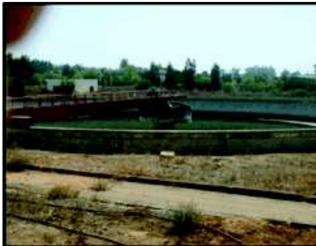
Figure VI.8 : Décanteur primaire de la STEP Baraki, année 2011
