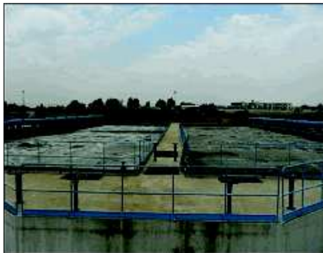
Figure VI.9: Bassin d'aération de la STEP Baraki, année 2011
