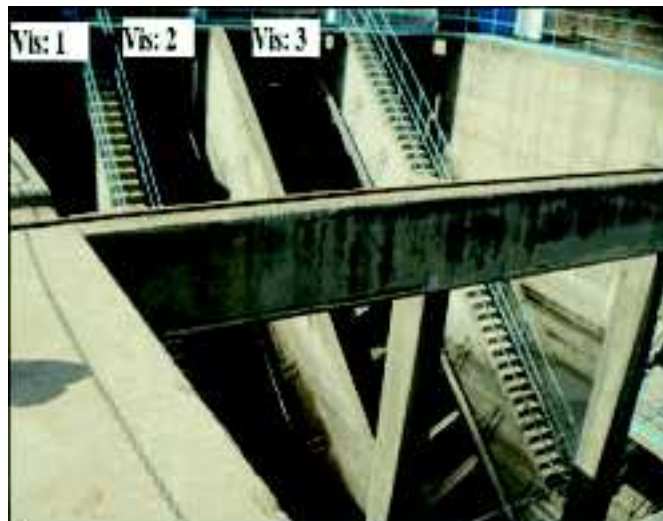
Figure VI.2: Poste de relevage PR1 de la STEP Baraki, année 2011
