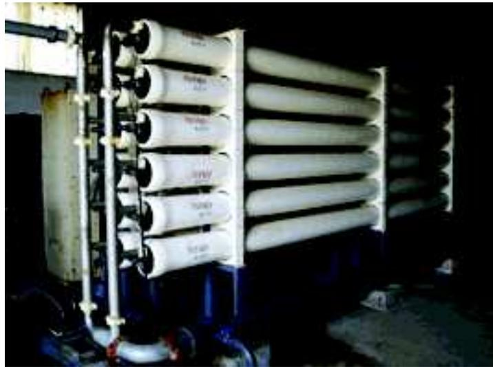
**Figure 23:** Tubes de pression (Châssis).
